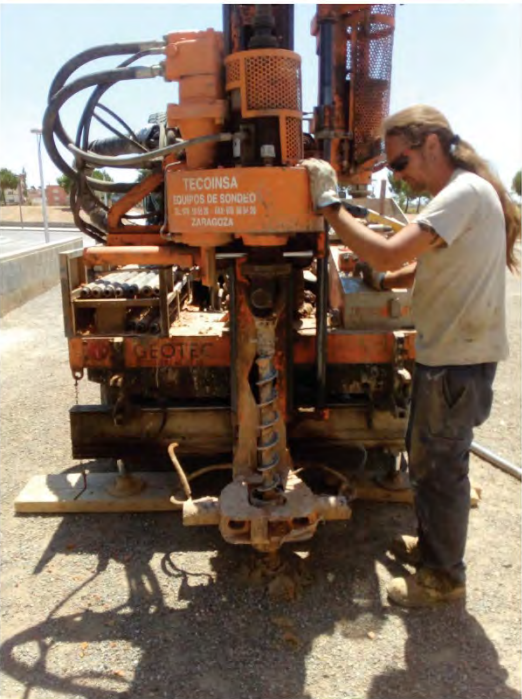
Vistes dels tres sondeigs realitzats al solar objecte d'estudi, P-1 del tipus DPSH i S-2 i S-3 del tipus Rotació helicoidal.
